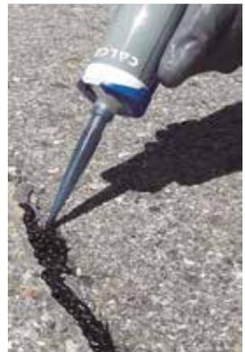
**Reparación de hormigón no estructural**
