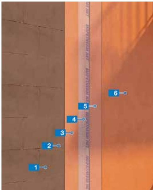
1. SATE existente fisurado
