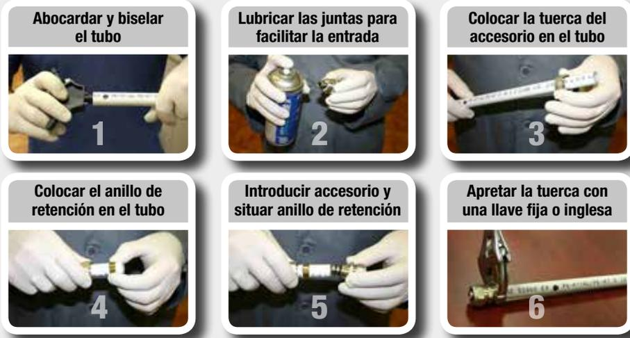
**ACCESORIOS PRESS PARA SISTEMA MULTICAPA (máquina) | Isoltubex**
